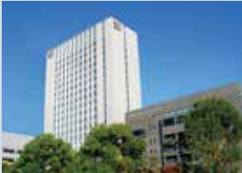
本社 および R&D センター 国内販売会社 大阪本社
